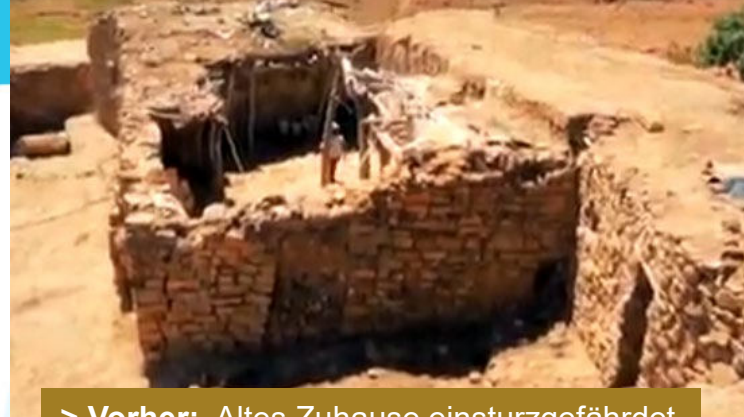
> Vorher: Altes Zuhause einsturzgefährdet
